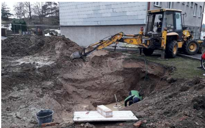
Práce na opravě vyžadovaly i těžkou techniku!
